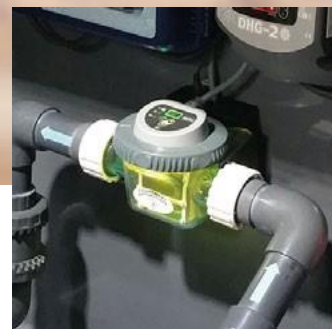
Монтаж хлоратора
